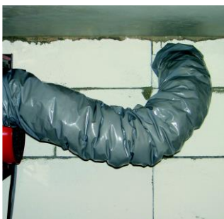
Korrekt montering, svag böj.
